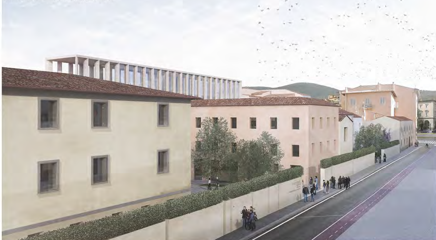
VISTA DEL COMPLESSO DA VIA CAVOUR
